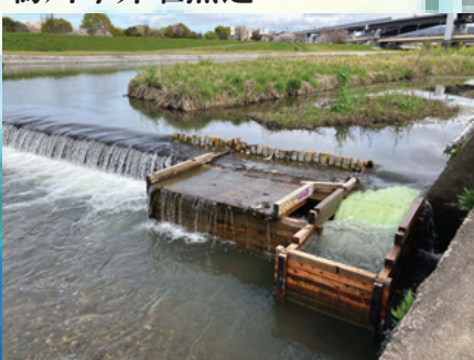
鴨川今井堰魚道
